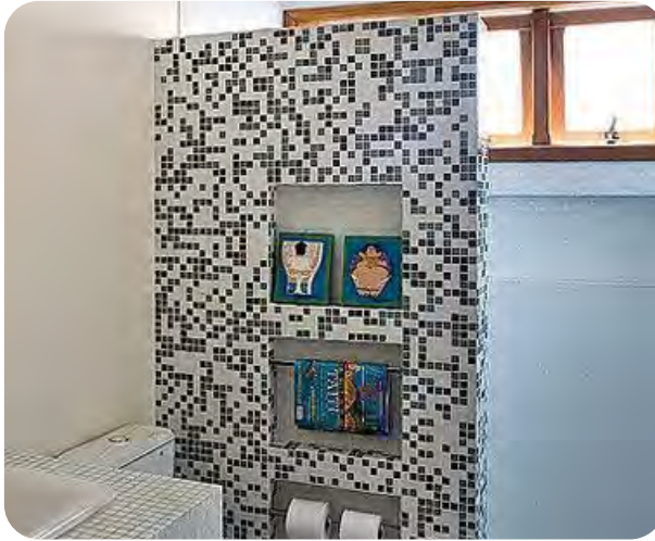
Divisória em Alvenaria Revestida
