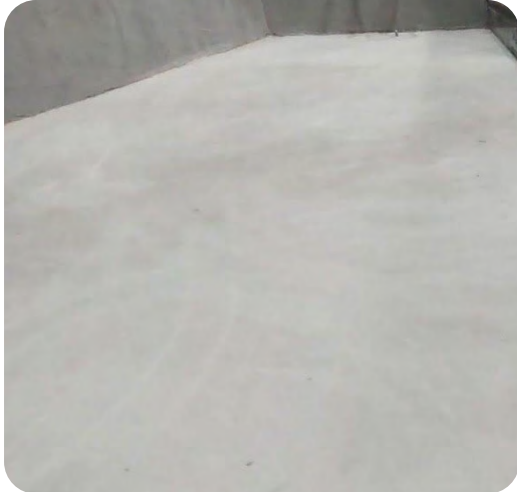
Piso de Cimento Queimado
