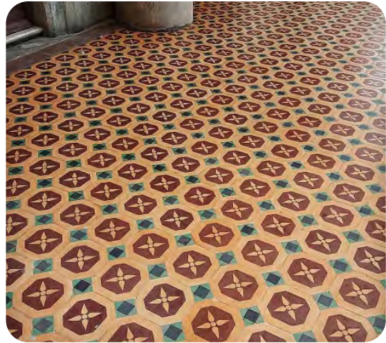
Piso de Ladrilhos
