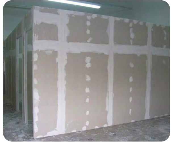
Divisória em Drywall
